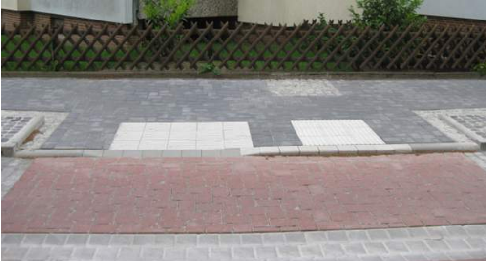
Abb. 5.15: Rethen / Steinweg: Taktile Leitelemente im Zuge eines Schulwegs
