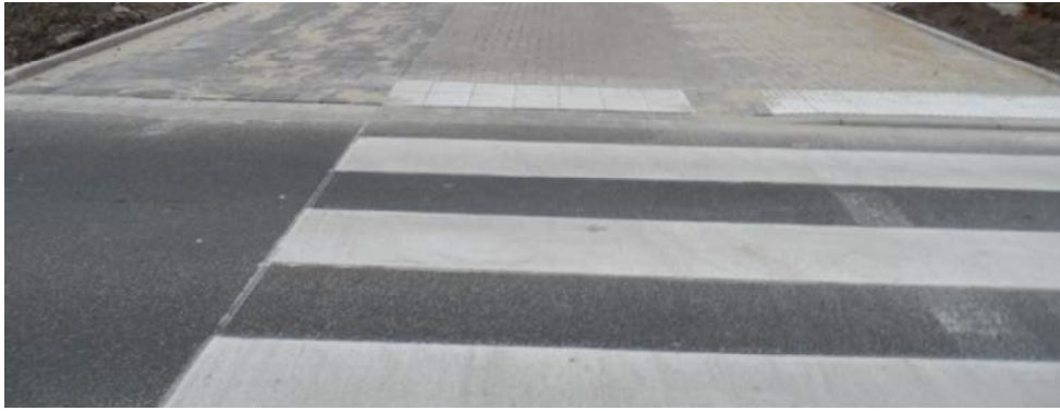
Abb. 5.13: Laatzten-Mitte - Marktstraße: Barrierefreier Ausbau Kreisverkehrsplatz
