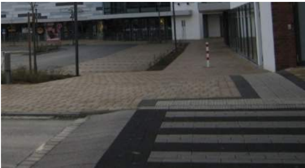
Abb. 5.14: Laatzten-Mitte / Robert-Koch-Straße: Taktile Leitelemente Höhe Querung FGÜ zum Leine-Center
