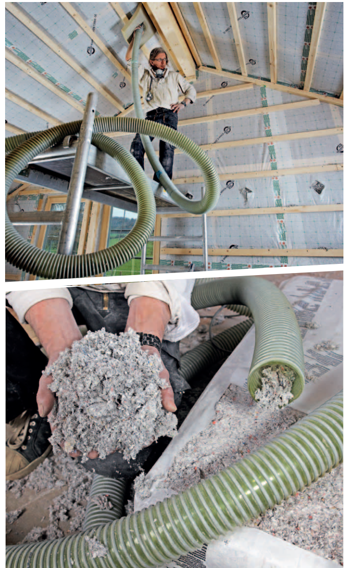
Einblasdämmung von Zellulose
