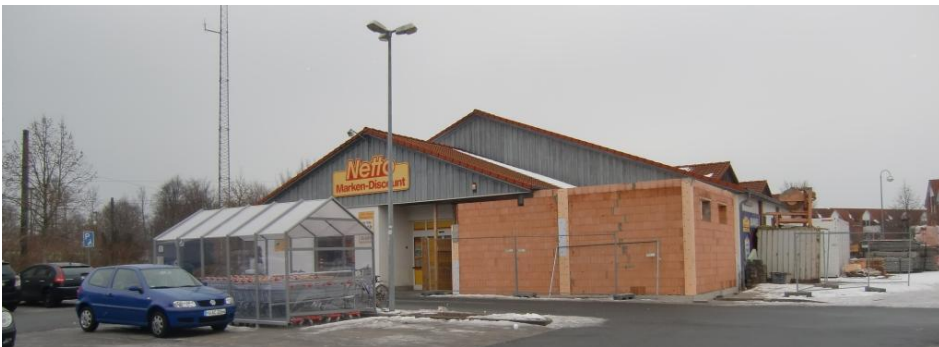
Abb. 44: Netto, Pattenser Straße (Rethen)
