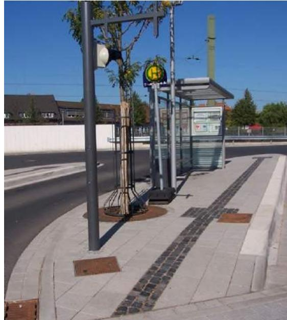
Abb. 5.11: Beispiel: Barrierefreie Haltestelle mit Aufmerksamkeitsfeld und Leitstreifen aus Kleinpflaster (Bahnhof Burgdorf)
