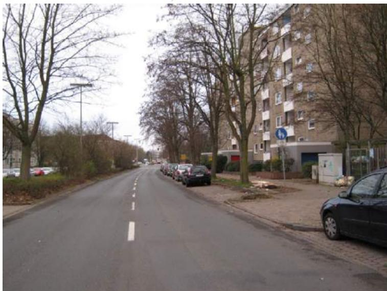
Foto 3.2: Überdimensionierter Querschnitt und mangelnde Querbarkeit in der Wülfeler Straße
