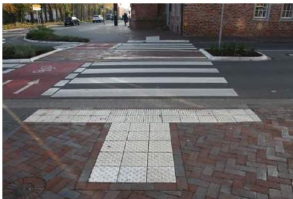
Foto 6.2: Beispiel Querungsstelle mit taktilen Elementen und Nullabsenkung
