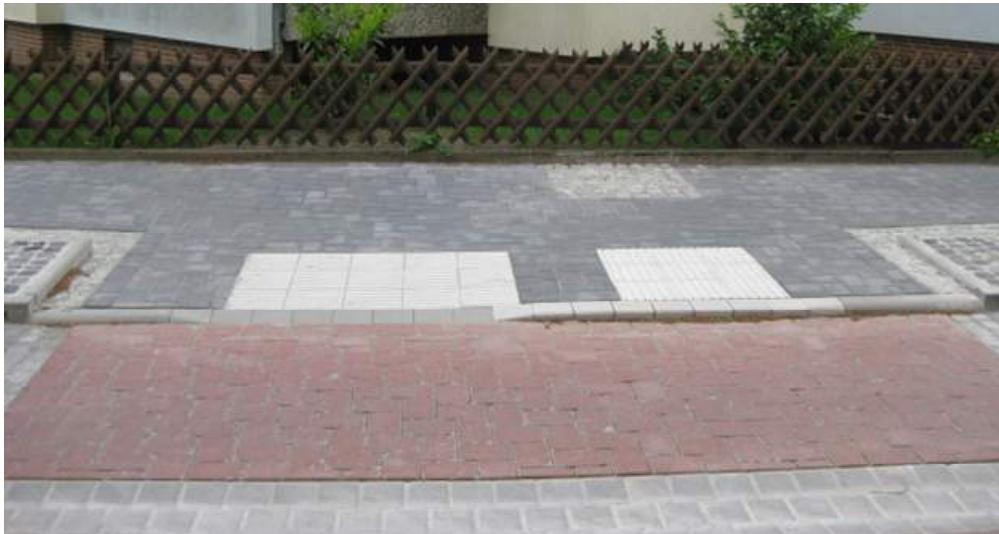
Abb. 5.15: Rethen / Steinweg: Taktile Leitelemente im Zuge eines Schulwegs
