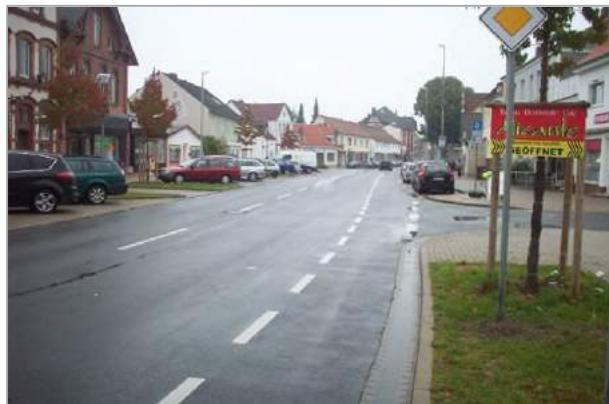
Abb. 5.2: Schutzstreifen für Radverkehr, Beispiel aus Burgdorf
