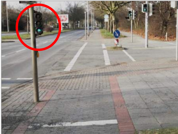
Abb. 5.3: Eindeutige, separate Radsignalisierung vor dem Knotenpunkt, Beispiel aus Hannover
