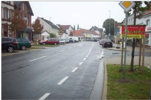
Abb. 5.2: Schutzstreifen für Radverkehr, Beispiel aus Burgdorf
