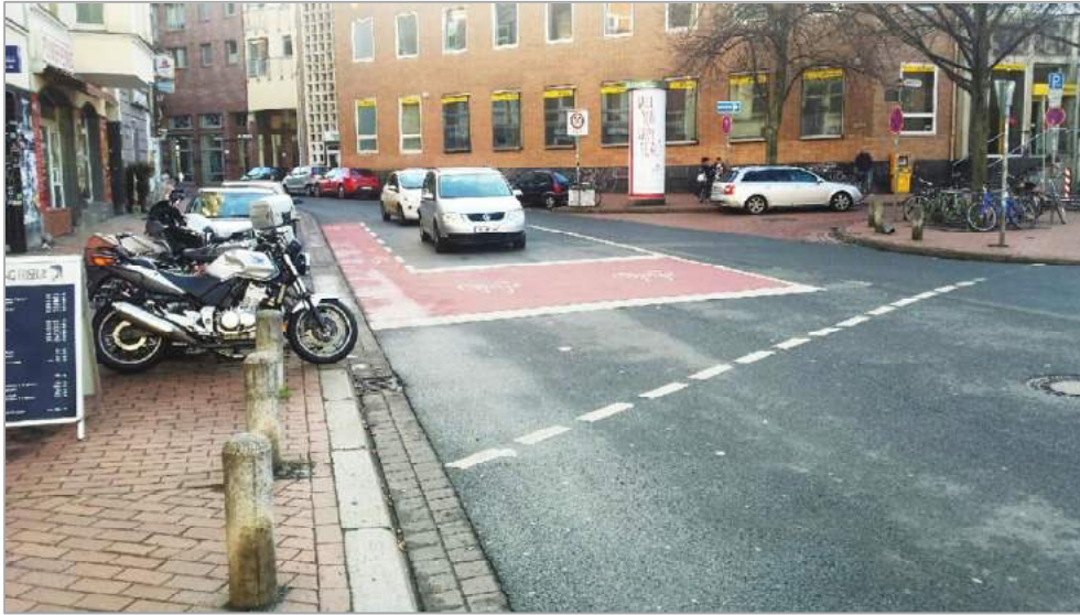
Abb. 5.5: Vorgezogene Aufstellfläche, Beispiel aus Hannover
