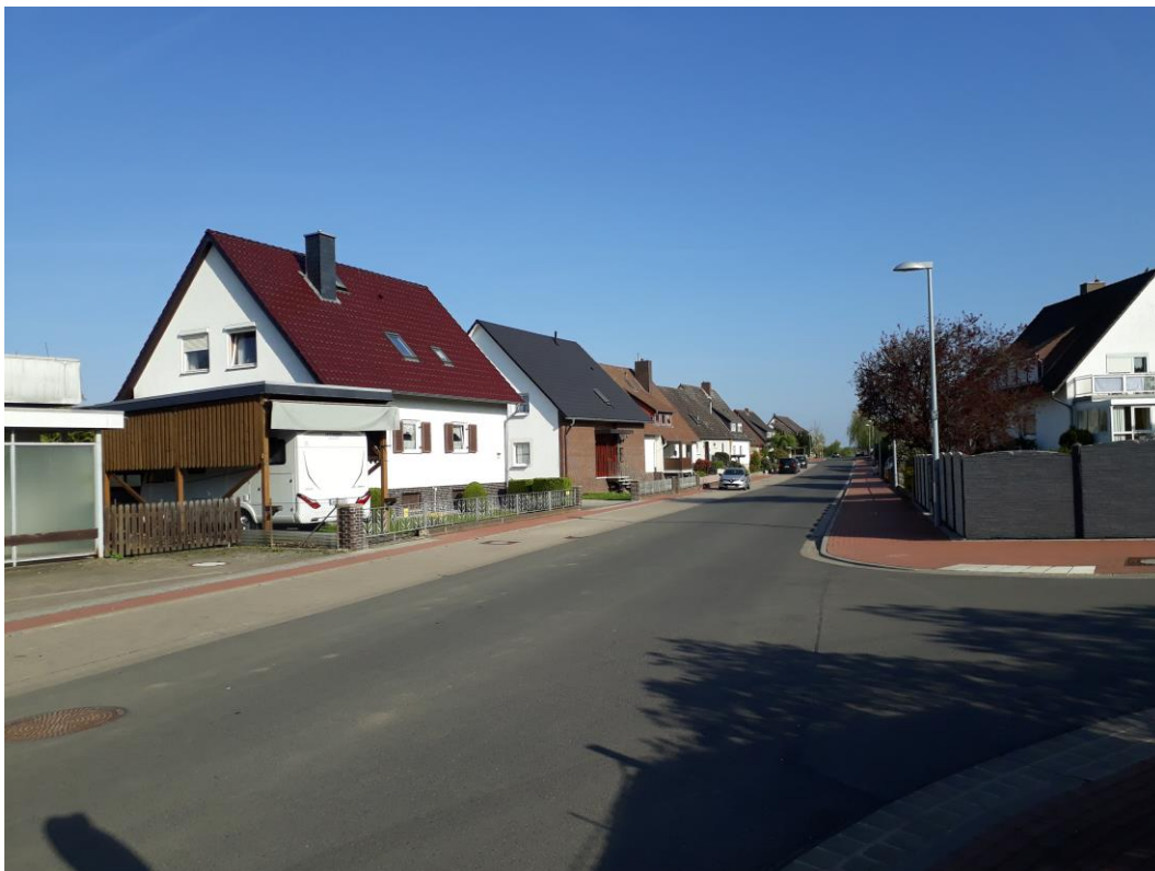
Abbildung 2-1: Blick längs der Straße „Am Holztor“ in nordwestlicher Richtung
