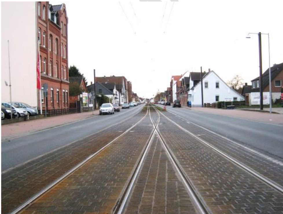
Foto 3.6: Eingleisige Streckenführung in Grasdorf
