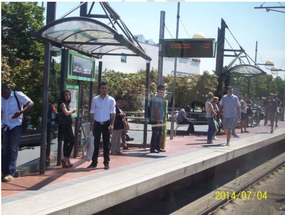
Foto 3.8: Moderne Haltestellenanlage Laatzten(-Zentrum)
