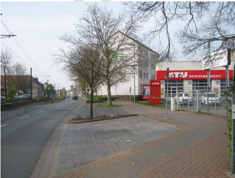
Foto 3.4: Verbesserungswürdige Linienführung des Radweges...
