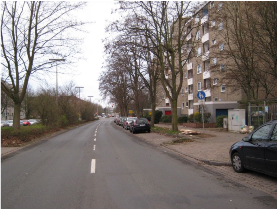
Foto 3.2: Überdimensionierter Querschnitt und mangelnde Querbarkeit in der Wülferoder Straße
